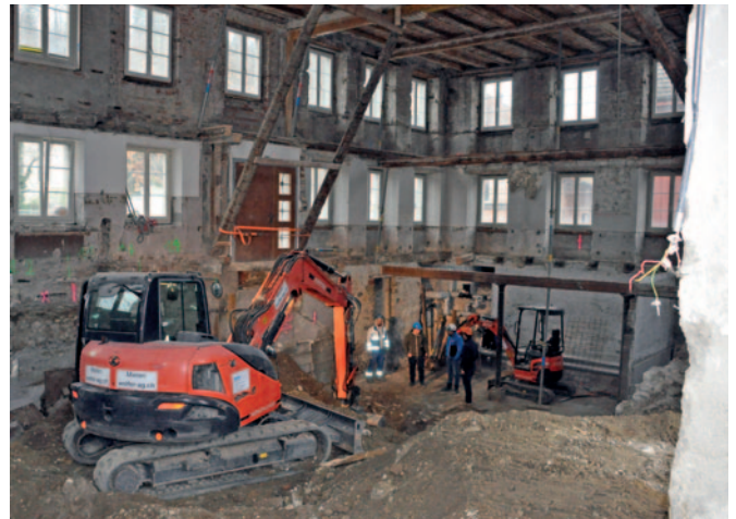
Besprechung auf der Baustelle.
