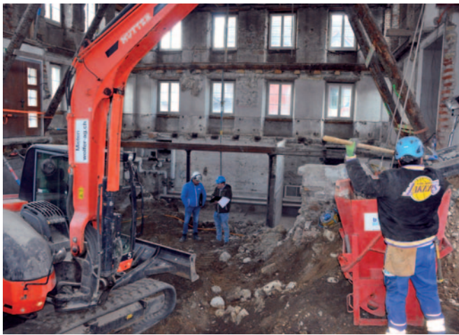
Aushub vom vergrößerten Keller.
