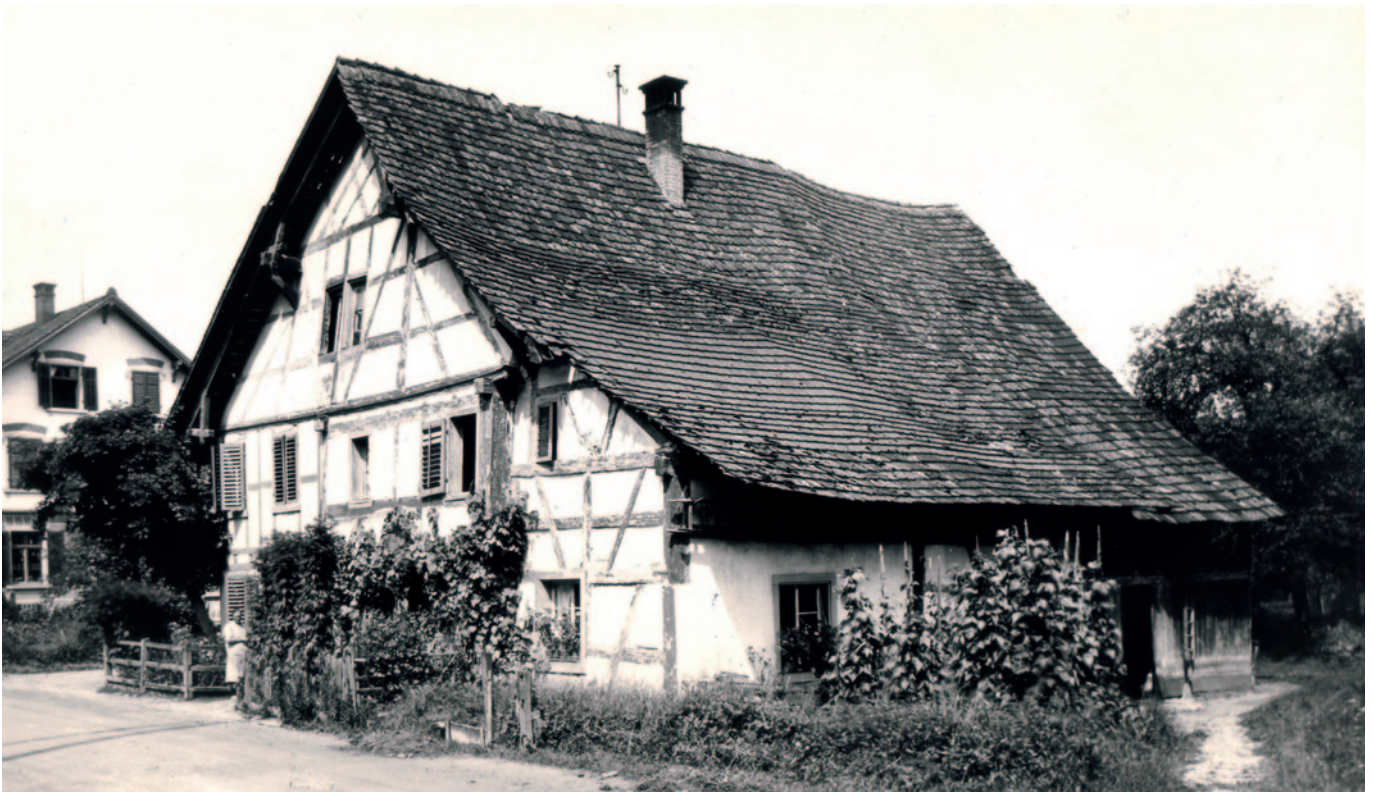
Das ehemalige Wohnhaus an der Hauptstrasse 16
