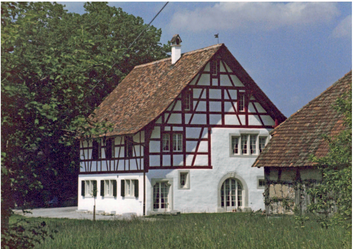
Bild oben: Die alte Schlosstrotte mit Holzverschalung. Unten zu sehen das heutige Gebäude, mit wiederentdeckter Riegelkonstruktion.
