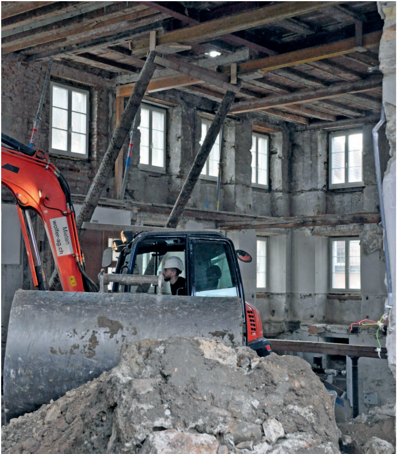
Spektakulär ist die Entkernung des Gemeindehauses. Stützmauern und Unterfangungen tragen das Gewicht der Aussenhülle. Bild: FlaaPo
