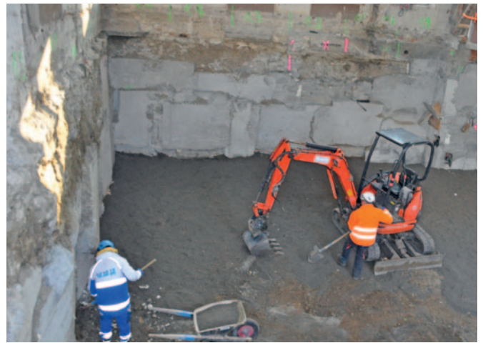
Einbringen der Kiesunterlage.
