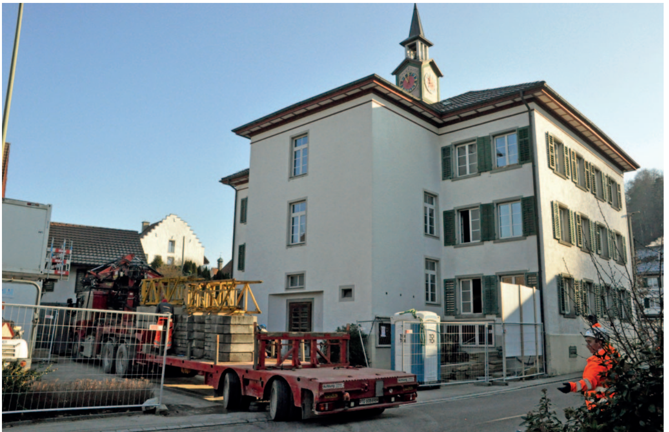
Anlieferung des Baukrans auf der Baustelle.
