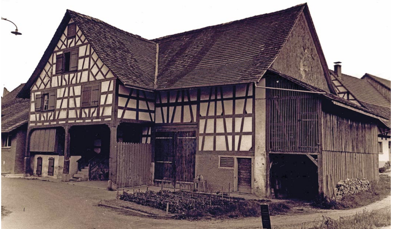
Haus im Moos von Fräulein Berta Gisler und später Jakob und Emma Fehr-Hurter, vor der Renovation
