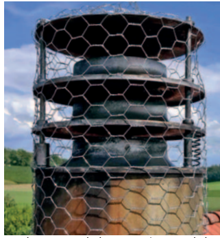
Mit diesem Vogelschutzgitter (nur vertikal montieren!) lässt sich die Gefahr bannen.
