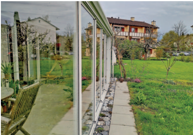
Um Kollisionen zu vermeiden, werden die Fensterfronten dieses Wintergartens nun vogelfreundlich nachgerüstet.
