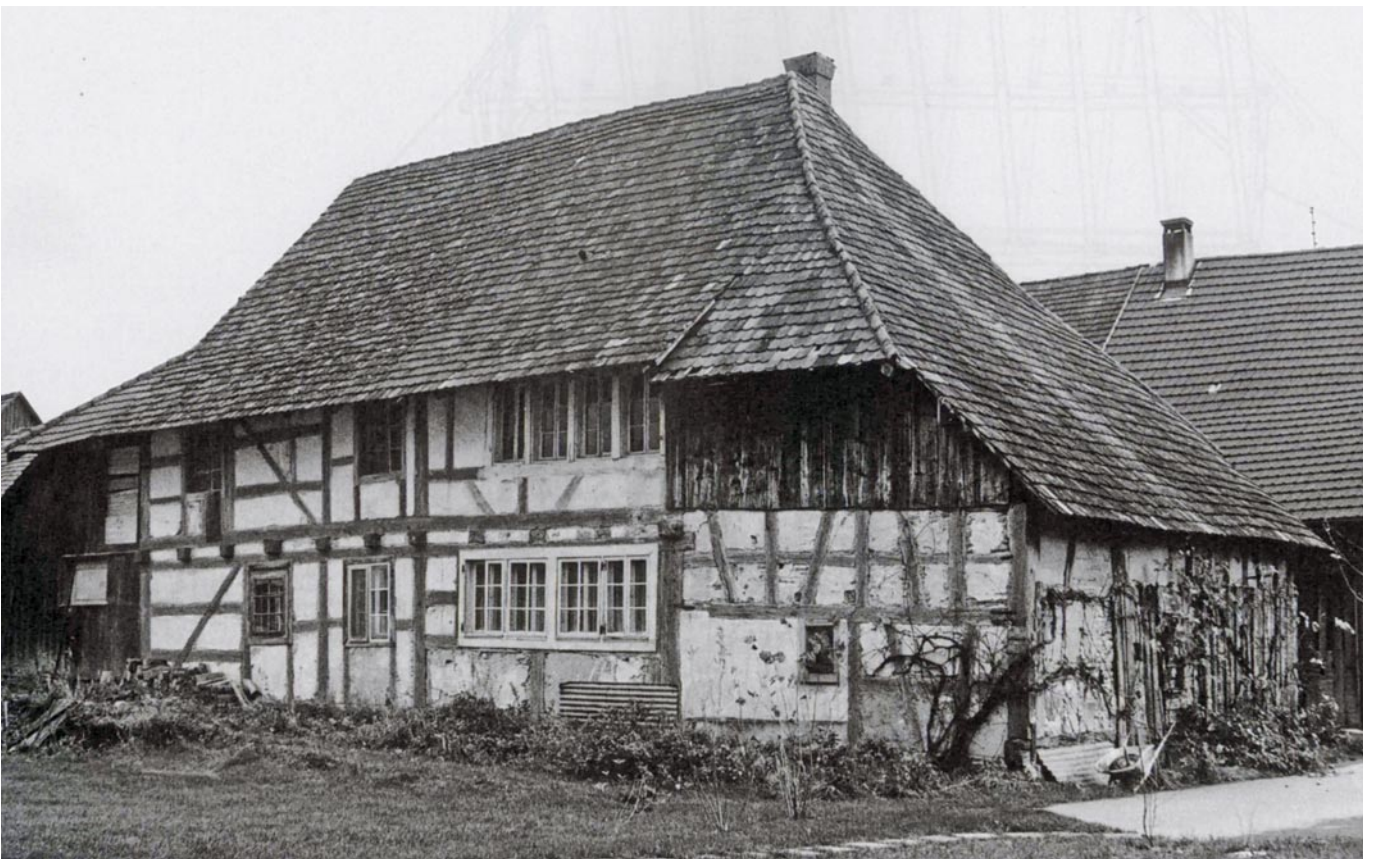
«Auf der Platte», Blick von der Schlosstrotte her. Die beiden übereinander liegenden Wohnungen sind gut ersichtlich. Die Fenster der Kammern und Stuben werden von Riegeln eingefasst. Im Dachgeschoss besteht heute eine weitere Wohneinheit.
