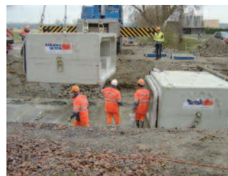
Versetzen der ca. 25 Tonnen schweren Brückenelemente mit Spezialkran
