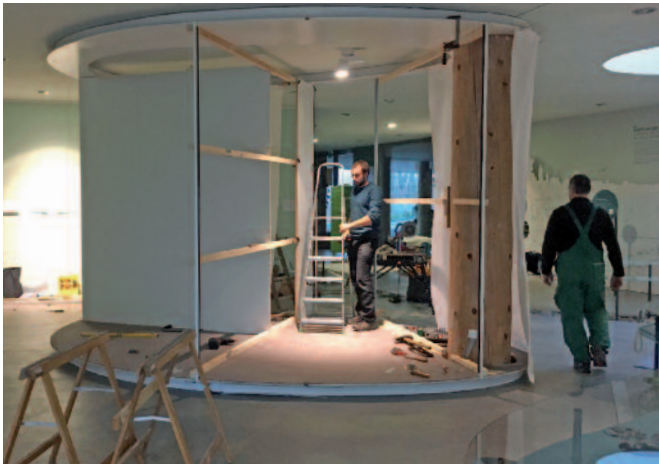
Umbau des Pavillons in der Ausstellung des Naturzentrums
