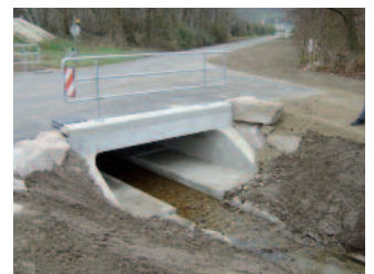
Die fertige Brücke am 16. Dezember 2016
