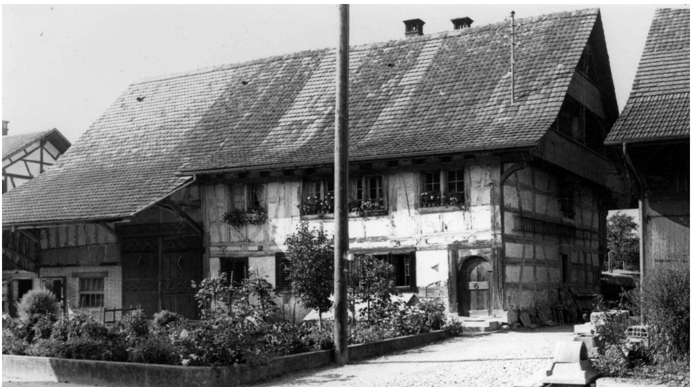
Das Haus Strehlgasse 10 vor der Renovation Anfang der Fünfzigerjahre des letzten Jahrhunderts.
